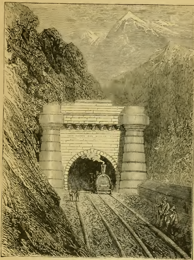
FIG. 45. — ENTRÉE DU TUNNEL, DU CÔTÉ DE BARDONNECHÉ (ITALIE)
